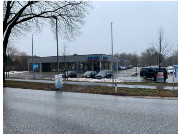
Osterrönfeld, SO-NVZ Verkehrskreisel: Aldi-Untersuchungsobjekt Blick von der Kieler Straße, vorgelagerter komb. Fuß-/Radweg
