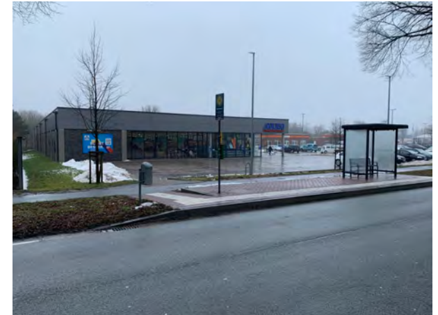
Osterrönfeld, SO-NVZ Verkehrskreisel: Aldi-Untersuchungsobjekt Blick von der Kieler Straße, vorgelagerter Fuß-/Radweg/ ÖPNV-Bushaltetele
