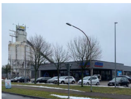
Westerrönfeld, SO-NVZ Am Busbahnhof: Aldi
